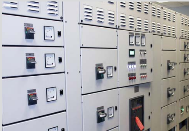
Низковольтные распределительные устройства
